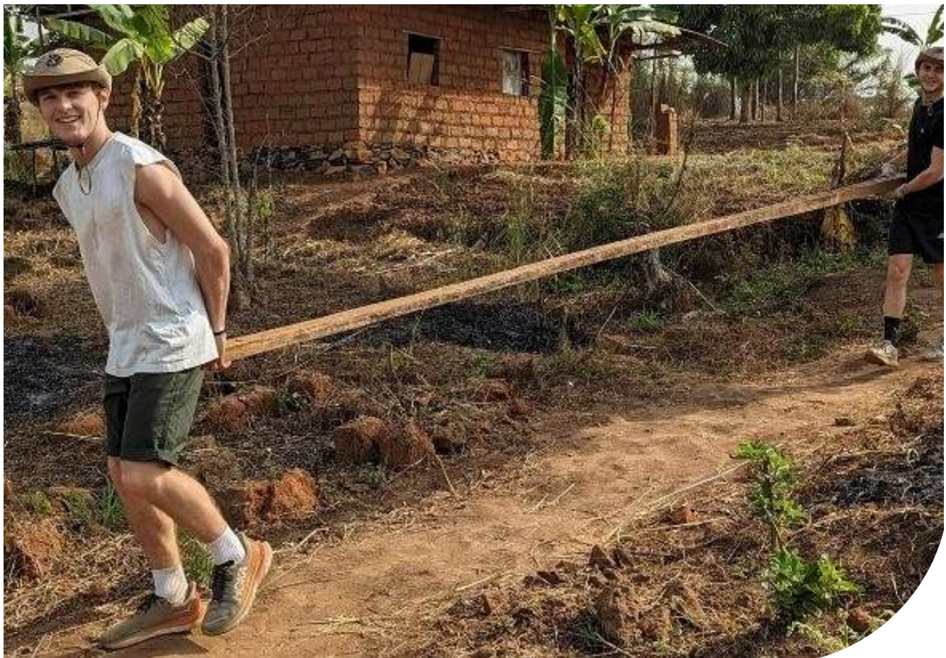
Les jeunes bénévoles transportant des matériaux pour les nouvelles salles de classe - Chantier de Solidarité à Metchou avec l'UTC (Université de Technologie) de Compiègne
